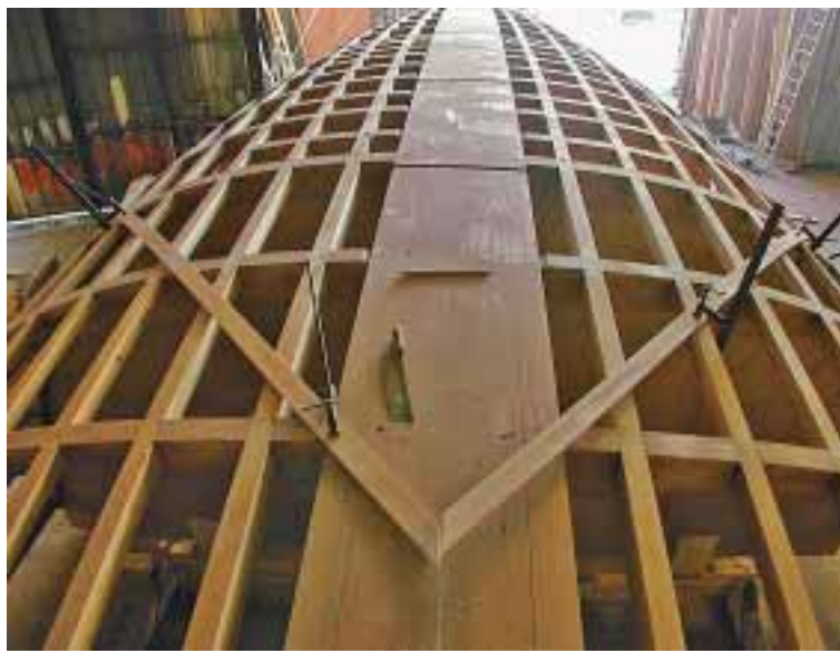
Figure 8 e 9 Ultimata la “cesta” si procede al posizionamento del primo strato di fasciame.
