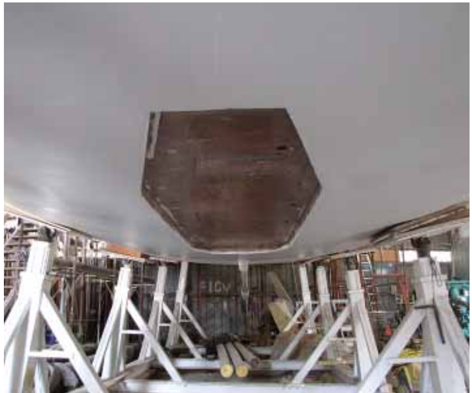
Figura 15 - Sul fondo dello scafo si vede l'alloggiamento per la piastra che costituisce la testa del bulbo: una volta in posizione si troverà a filo scafo.
